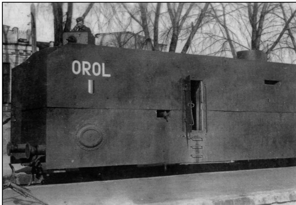
Gulometný vagón slovenského IPV. Na streche má dve gulometné vežičky zo sovietskych tankov. Vľavo od vstupných dverí vidno strieľňu s ťažkým gulometom vz. 24, vpravo hore od dverí je pod tankovou vežičkou strieľňa pre ľahký gulomet vz. 26. Pod bielym nápisom OROL vidno slovenskú trikolóru používanú od roku 1942 na označenie slovenských obrnených vozidiel. (Foto: Zbierka M. Lacko)
